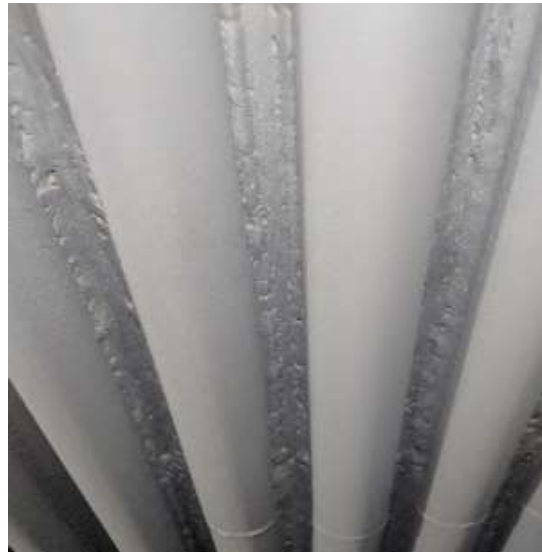
Gambar 6. Kondisi pipa yang sudah dilakukan sand blasting dan repaire
