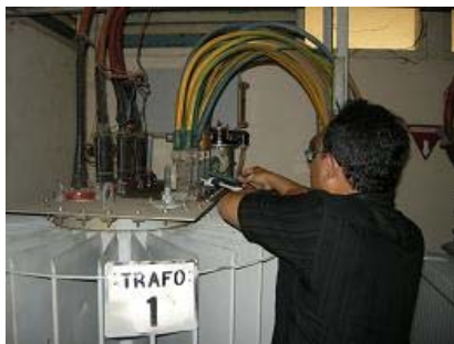
Gambar 6. Pemasangan Alat Ukur A3Q pada sisi sekunder Transformator Distribusi
