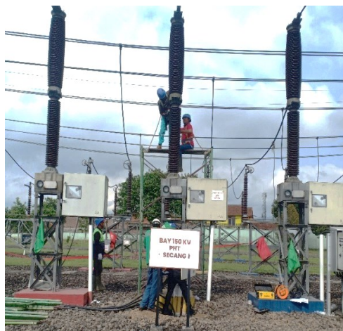
Gambar 1. Pemutus Tenaga (PMT) pada Gardu Induk Sanggrahan
