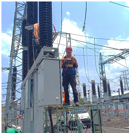
Gambar 2. Pengujian tahanan isolasi pada PMT
